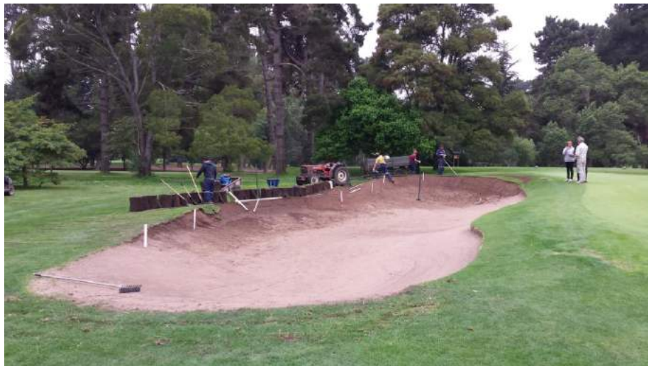
Detalle de intervención en bunker izquierdo de hoyo 3 rojo.
