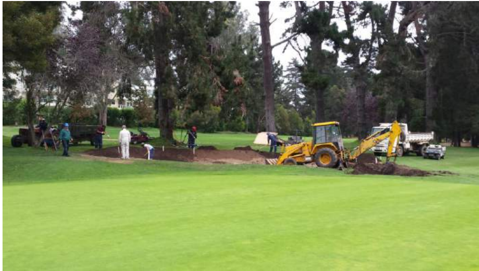
Detalle de intervención en bunker derecho de hoyo 4 rojo.
