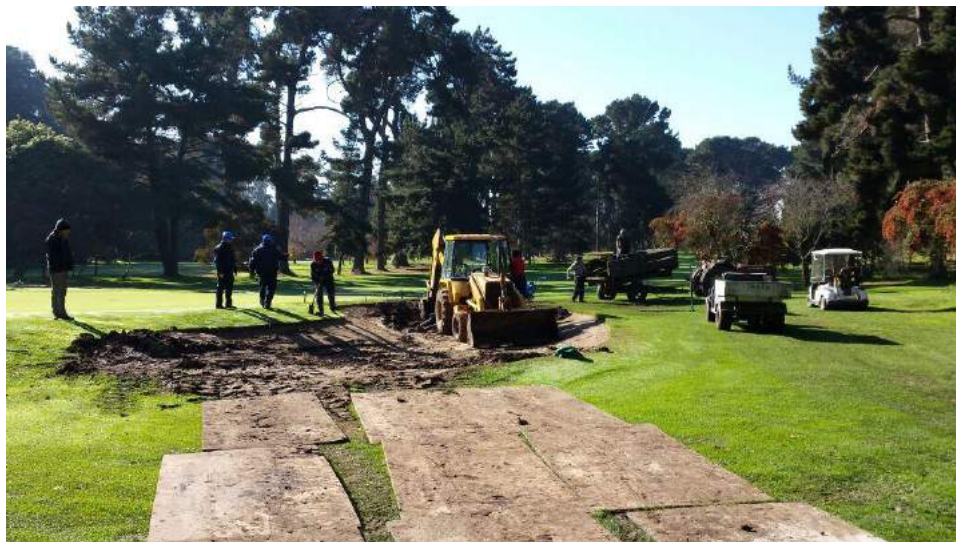
Detalle de intervención en bunker izquierdo de hoyo 2 azul.
